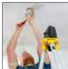
Vedení trubek - od podlahy ke stropu
