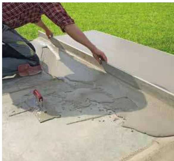
Stahovací lať lze nastavit až do spádu 4% aniž by vzniklo riziko stečení nivelační vrstvy.
