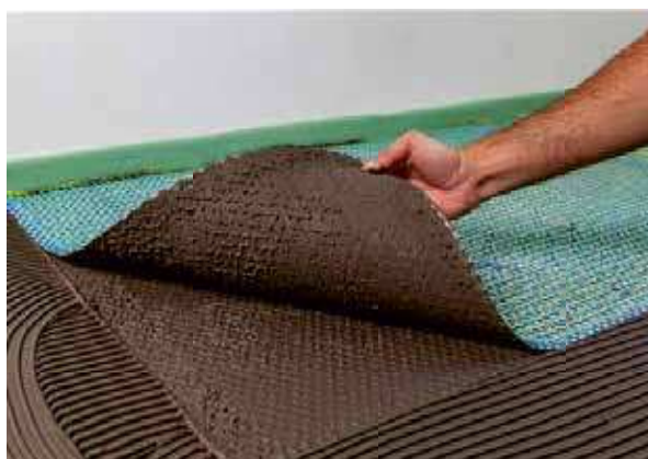
2. Vložte codex UX 430 do malty a dobře ji vetřete.
