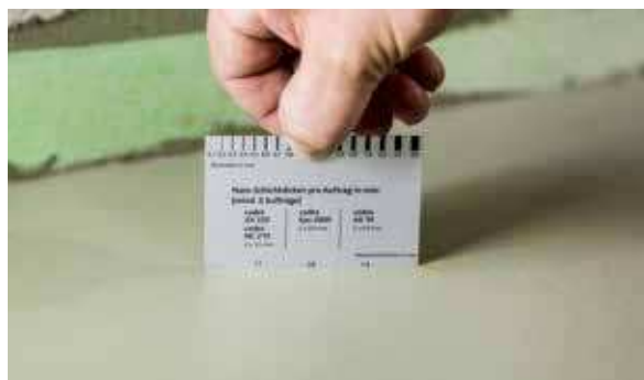
Nejprve se připraví kontaktní vrstva a pak se 4 mm ozubenou stěrkou připraví vlastní vrstva. Hladkou stranou se izolace uhladí. Po zaschnutí se připraví druhá vrstva.
