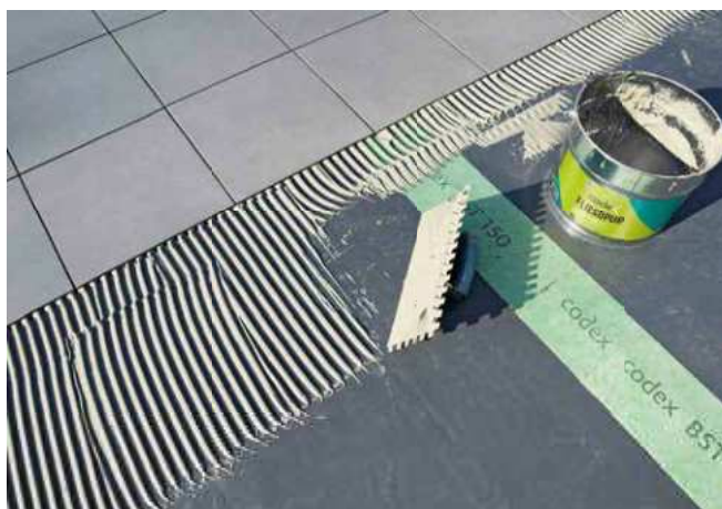
codex BalkuSlim® nainstalovaný v systému s UZIN RR 185 a codex BST 150
