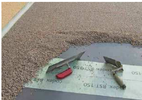
codex BalkuDrain® nainstalovaný v systému s UZIN RR 185 a codex BST 150.
