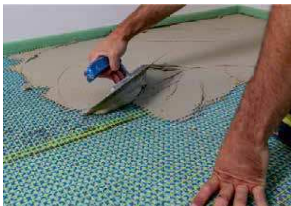
4. Mřížovou konstrukci vyplňte pokládací maltou a poté vhodnými zářezy zachovat čerstvé v čerstvém.
