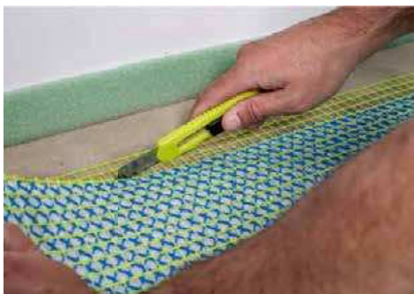
1. Před položením první řady odřízněte přebytečnou délku nožem nebo nůžkami.
