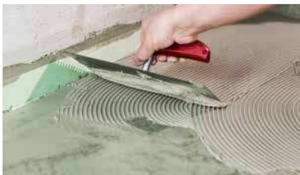
AX 230 se rozleje do koutu a rovnoměrně rozprostře po podkladu
